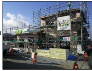
山元町災害公営住宅の工事状況
