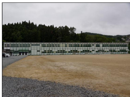
宮城県気仙沼向洋高等学校仮設校舎
