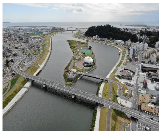
(国) 398号内海橋 (石巻市)
