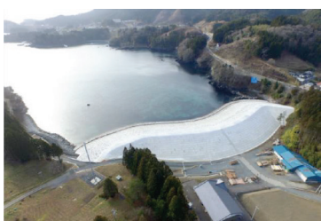
47 荒谷前地区海岸災害復旧工事
