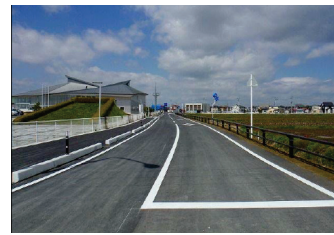
6 河北桃生線バイパスの供用開始
