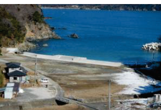
54 雄勝港「浪板防潮堤」
