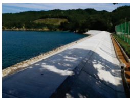
41 東侍浜海岸工事の竣工式
