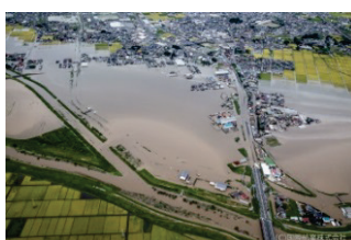
32 鳴瀬川水系渋井川堤防決壊
