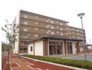
28 石巻災害公営住宅
