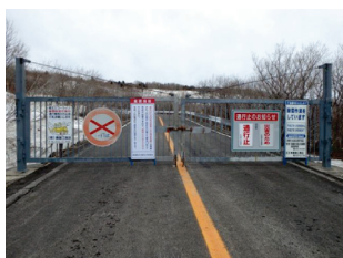
1 澄川ゲート通行止め
