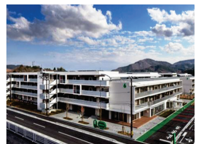
■ 写真 6-1-5：女川町運動公園地区
