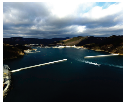
■ 写真 6-1-2：女川湾港防波堤工事
