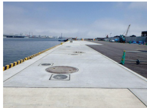
■ 写真 6-1-8：仙台塩釜港(塩釜港区) 東ふ頭岸壁 (塩竈市貞山)
