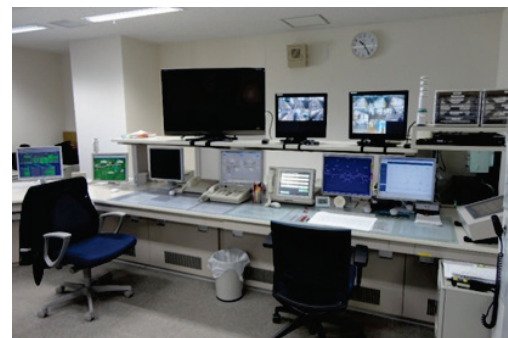
■ 写真 6-1-9：運輸司令室を2階へ (仙台空港鉄道株式会社)
