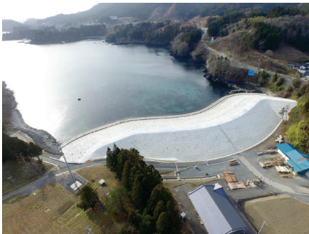
■ 写真 6-1-1：荒谷前地区海岸災害復旧工事
