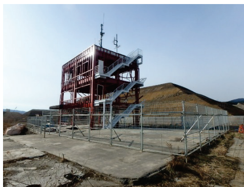
■写真 6-1-11：南三陸町旧防災対策庁舎
