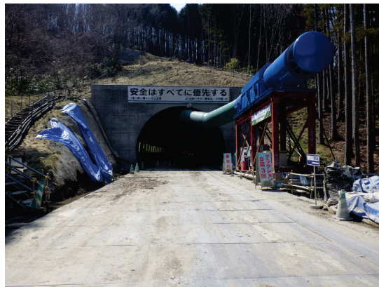
■ 写真 4-3-6：トンネル施工状況
