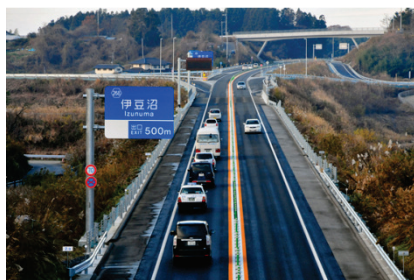
■ 写真 4-3-1：平成23年11月供用開始 Ⅰ期区間
