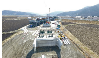
■ 写真 4-3-8：II 期大瓜工区の整備状況
