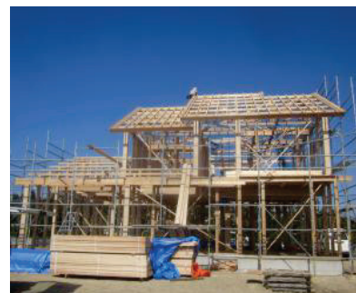
■写真 4-2-27：県産材を使用した住宅建設の様子
