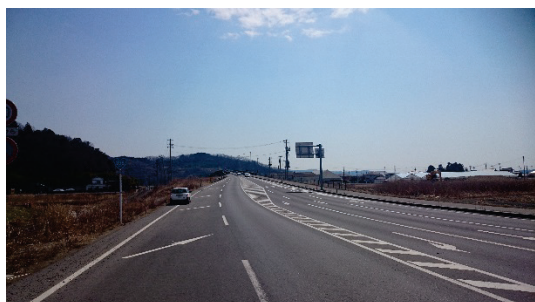
■ 写真 4-3-7：平成 21 年度供用開始 I 期南境工区
