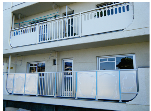
■ 写真 2-1-22：復旧完了（平成23年11月）
