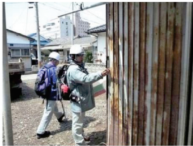
■ 写真 2-3-1：応急危険度判定活動状況
