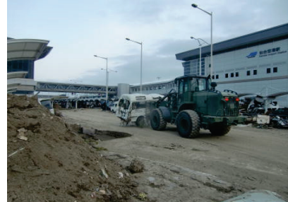
■写真 2-1-25：被災車両の撤去
