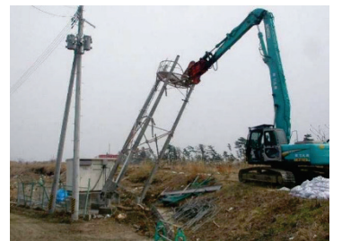
■写真 2-1-43：寺野警報局応急対応状況
