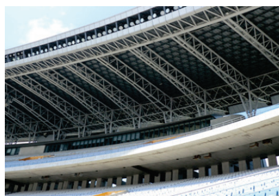
■写真 2-1-30：屋根T型梁の補強施工状況
