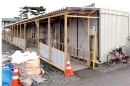
■写真 2-3-4：スロープ下屋の整備
