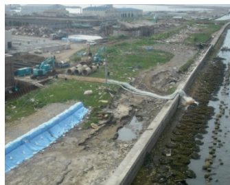
■写真 2-1-42：東部浄化センター 放流管応急復旧
