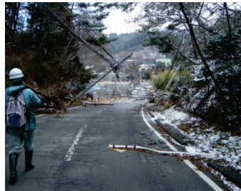
■写真 2-1-36：車両通行不能区間 現地確認状況
