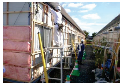
■写真 2-3-6：断熱材の追加
