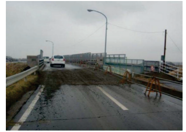
■写真 2-1-34：化粧坂橋応急対応状況
