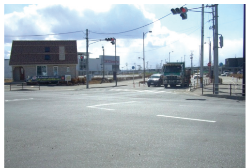
■写真 2-1-20：復旧状況（平成23年6月）
