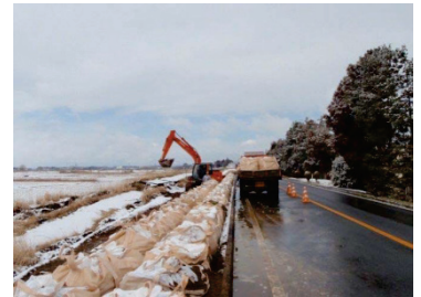
■写真 2-1-37：迫川堤防応急対応状況
