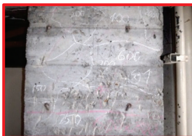
事務室内改修状況 （柱クラック モルタル補修）
