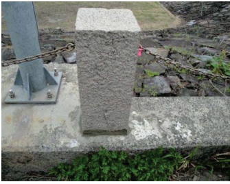
■写真 2-1-45：荒砥沢ダム防護柵復旧
