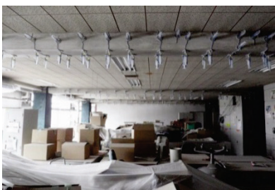
事務室内改修状況（梁クラック注入）
