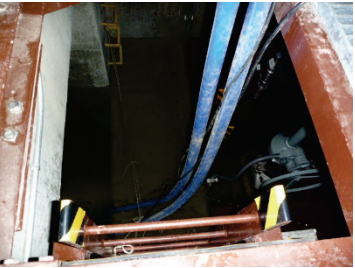
■写真 2-1-44：上大沢ダム応急対応
