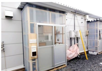
■写真 2-3-5：風除室の設置
