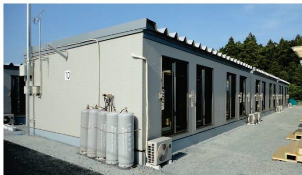
■ 写真 2-3-3：住宅部会のプレハブ仮設住宅
