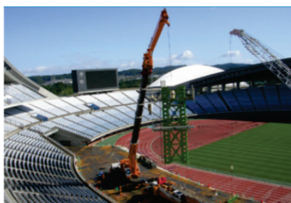
■写真 2-1-29：仮設柱の施工状況
