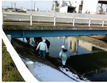
■写真 2-1-33：災害査定状況
