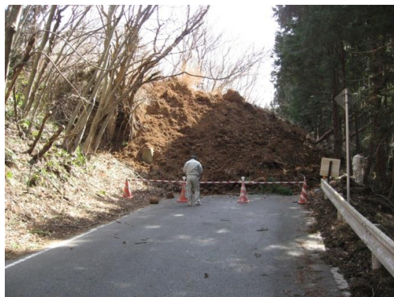
■写真 1-2-2：(主) 亘理大河原川崎線 (川崎町支倉)
