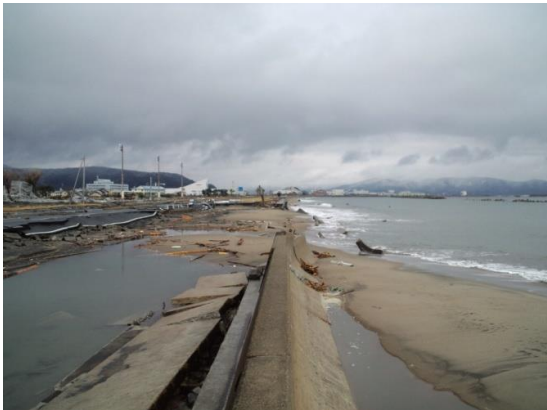
■写真 1-2-33：東浜防潮堤（石巻市雲雀野町）
