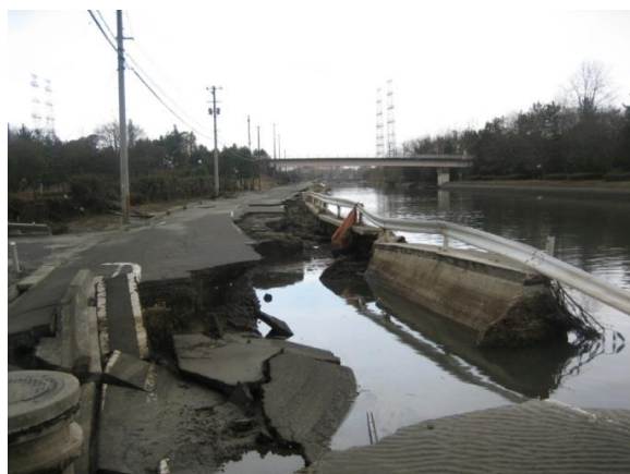
■写真 1-2-15 : 砂押貞山運河 (中南部下水道事務所付近)
