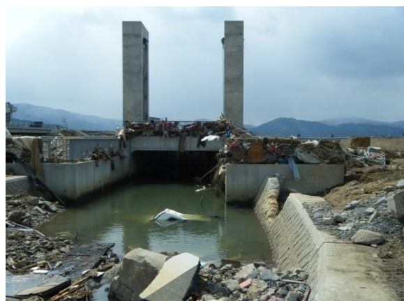
写真 1-2-22 : 大沢川分派水門 (石巻市北上町橋浦)
