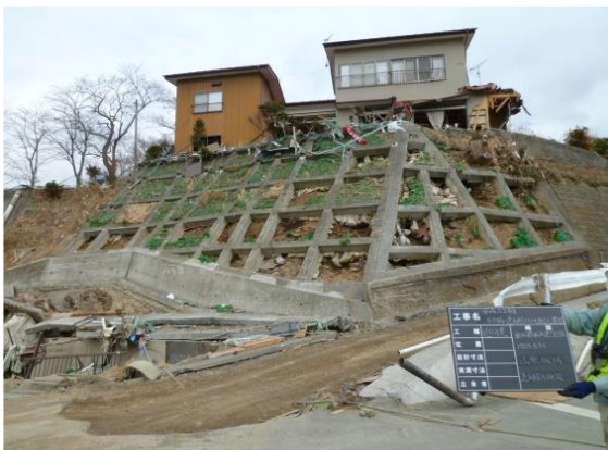
■写真 1-2-29 : 山根白場急傾斜地 (南三陸町山根城場)
