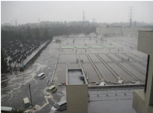
写真 1-2-37：仙塩浄化センター下水処理施設 (多賀城市大代)
