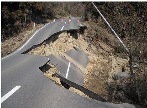
■写真 1-2-5：(主) 栗駒岩出山線 (大崎市岩出山堂の沢)
