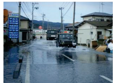
■ 写真 1-1-2：地盤沈下した県道（石巻市渡波）
