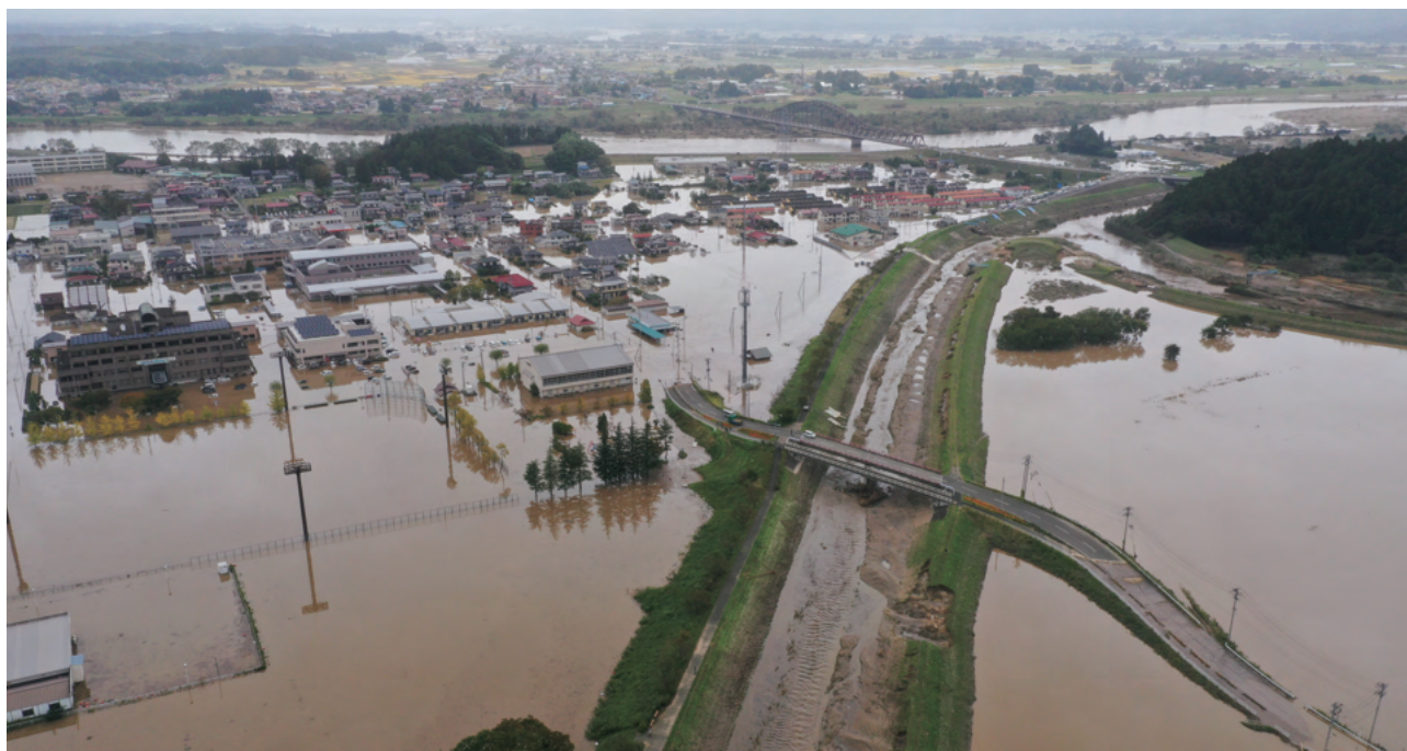
浸水した丸森町中心部
