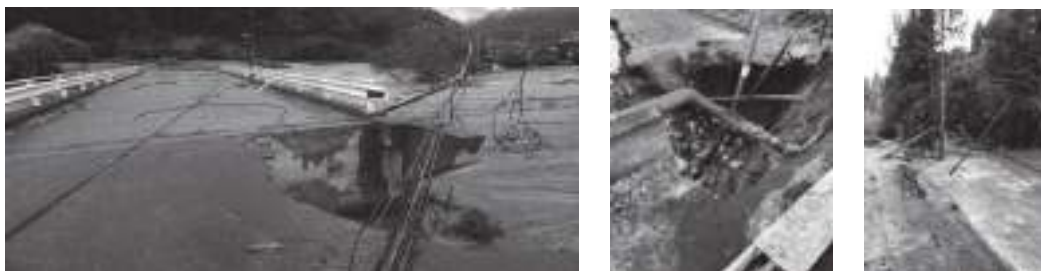
道路崩落・河川氾濫によるケーブル切断・電柱折損
