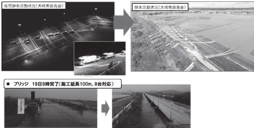
排水ポンプ車による排水活動（吉田川）
