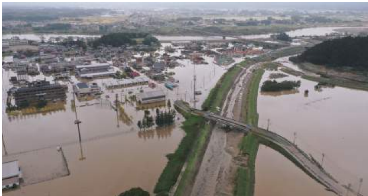
浸水した丸森町中心部
