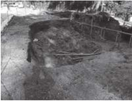
陥没，土砂流出した耕野小学校校庭
