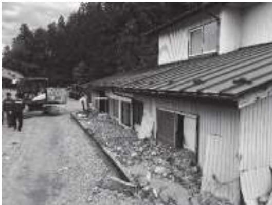
丸森町内の土砂堆積状況 (1)
