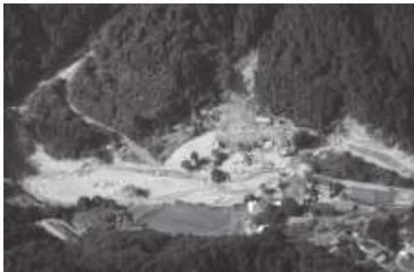
被災状況（ヘリ写真）（丸森町）
