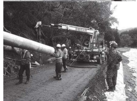
復旧作業の様子
