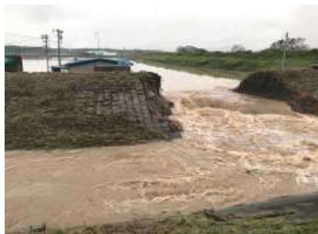
庄司堀川堤防決壊
