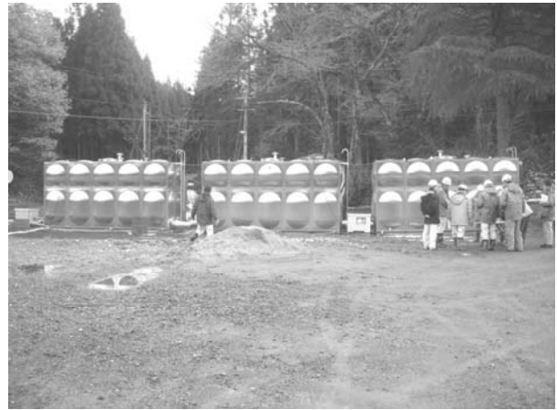
写真IX-10 栗原市小豆畑簡易水道仮設配水池
