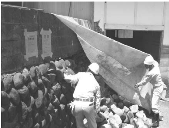
写真IX-6 判定活動（玉石積みの崩壊）
