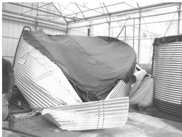
写真II-22 貯水タンクの破損 栗原市高清水
