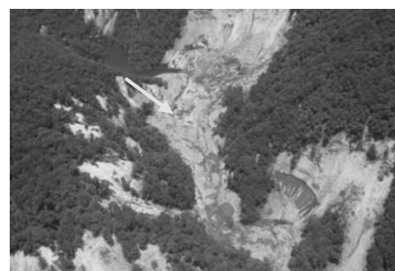
写真Ⅱ－16 迫川 湯浜の河道閉塞（天然ダム）の状況
