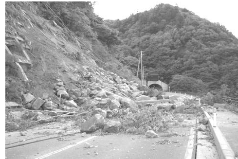
写真 II - 5 配電設備の被害状況写真②
