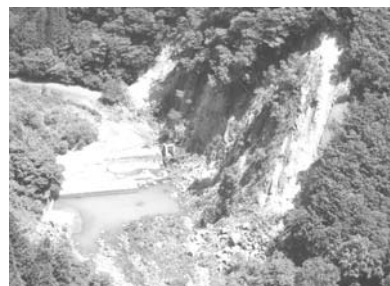
写真Ⅱ-1 花山発電所ダム周辺土砂崩落状況
