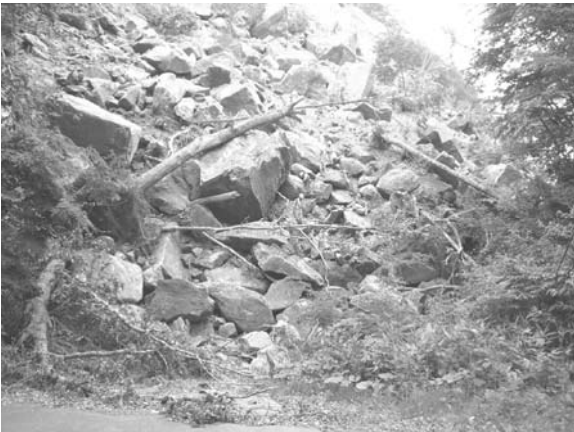
写真Ⅱ-11 行者滝上流地区被災状況
