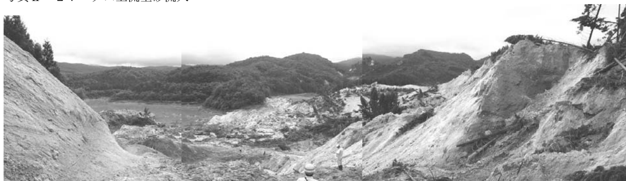
写真II-27 ダム上流土砂流入
