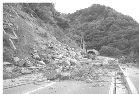
写真 II - 5 配電設備の被害状況写真②
