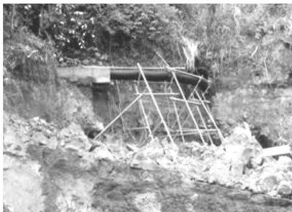
写真IX-14 用水路の応急復旧(栗原市旧栗駒町)
