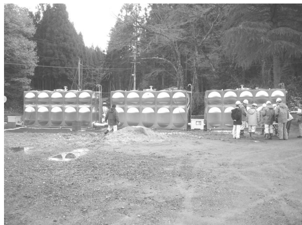
写真IX-10 栗原市小豆畑簡易水道仮設配水池
