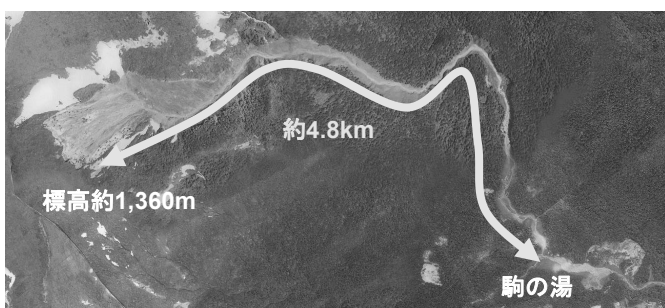
写真Ⅱ－15 土石流が発生した駒の湯温泉上流の状況
