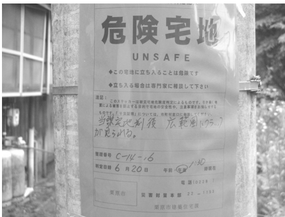
写真IX-8 判定の状況 （広範囲のひび割れ：「危険」の判定）
