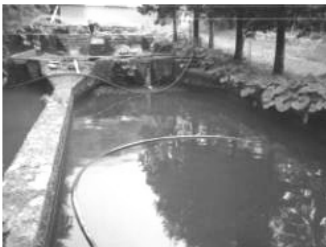
写真Ⅱ-28 破損により水位が下がり濁った養魚池（栗原市）
