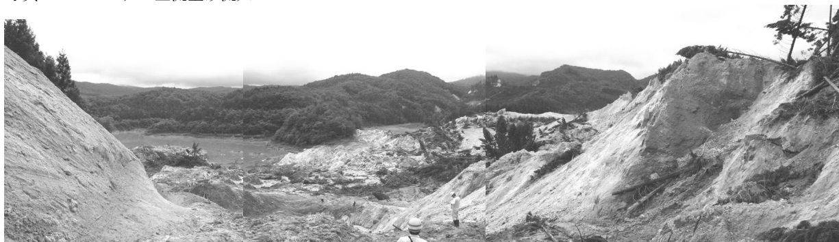
写真II-27 ダム上流土砂流入
