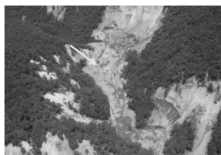
写真Ⅱ－16 迫川 湯浜の河道閉塞（天然ダム）の状況
