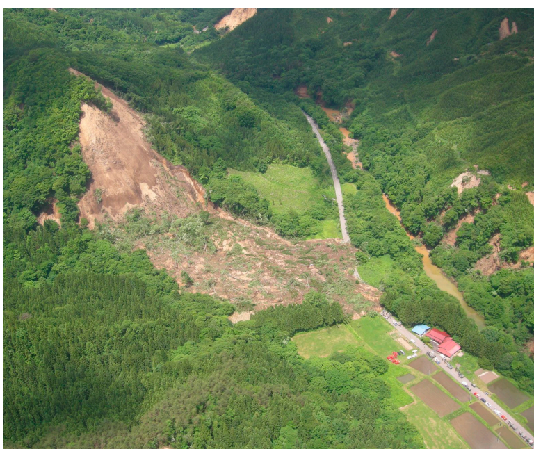
主要地方道築館栗駒公園線 栗原市栗駒放森地区 法面崩落状況
