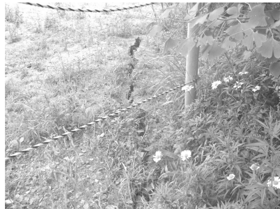
写真IX-7 被災状況（宅地のひび割れ）
