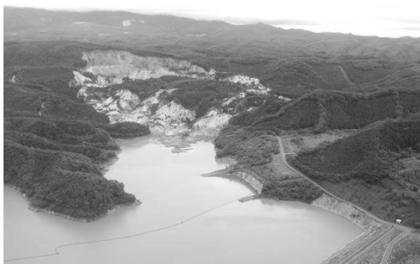
写真Ⅱ－13 荒砥沢ダム上部の地すべり（その1）
