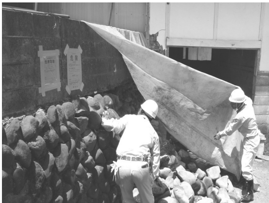
写真IX-6 判定活動（玉石積みの崩壊）
