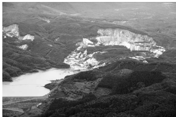
写真II-26 ダム上流崩落
