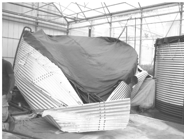
写真Ⅱ-22 貯水タンクの破損 栗原市高清水
