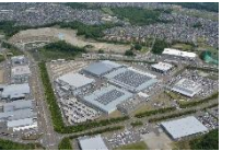
大和リサーチパーク
