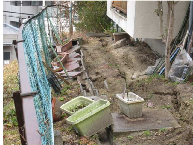
仙台市青葉区・黒松第一住宅 (H23.3.15)
