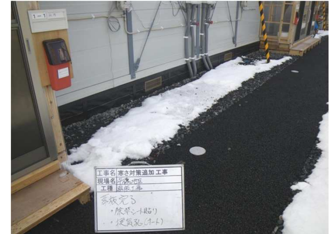
棟間舗装・凍結防止対策
