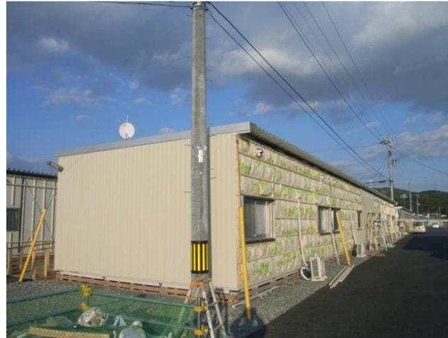
断熱材の追加、二重サッシ
