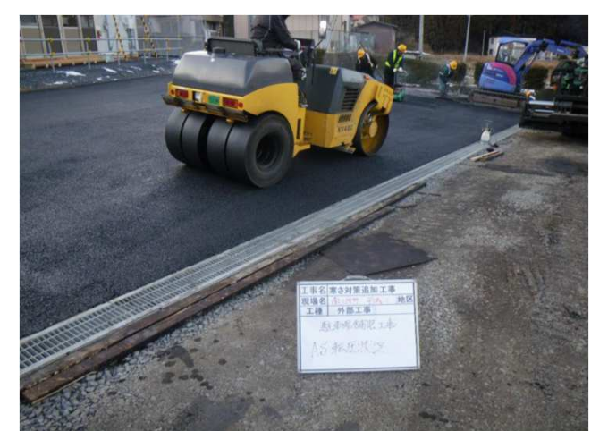
舗装・排水工事
