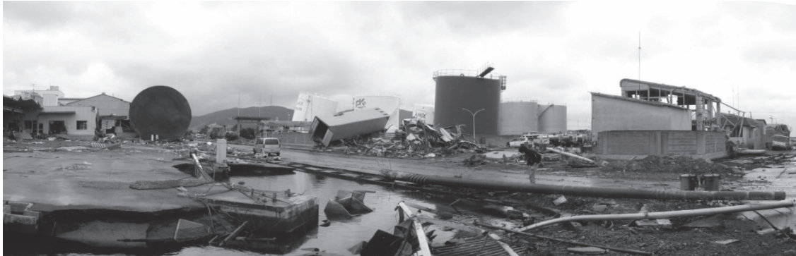
槽油所の重油タンクが倒壊し重油が流出
