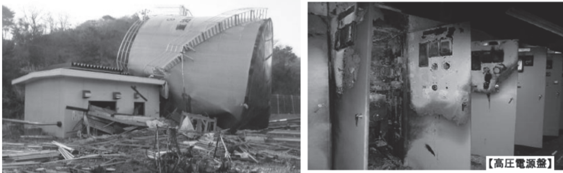
女川原子力発電所の被害の写真（重油タンク倒壊，高圧電源盤の火災の写真）
