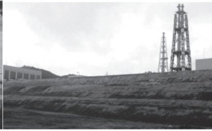
堤防かさ上げ
