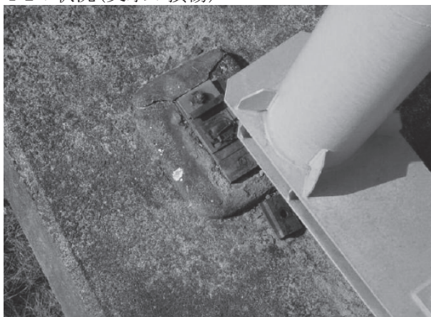
P1の状況(支承の損傷)
