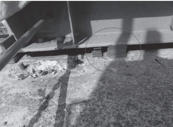
A1 応急復旧状況
