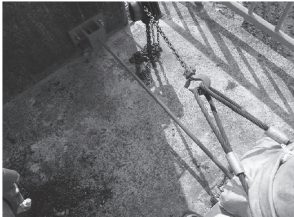
A1 応急復旧状況(ワイヤーによる落橋防止工)
