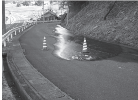
福岡浄水場 空気弁室からの漏水状況
