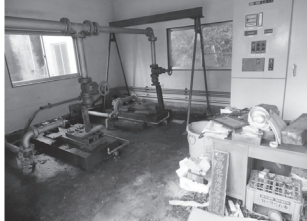
津波により浸水したポンプは修理中(操作盤も使用不可)
