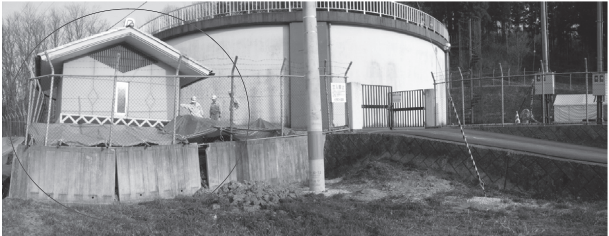
地盤崩壊によるポンプ室の傾斜及び損傷
