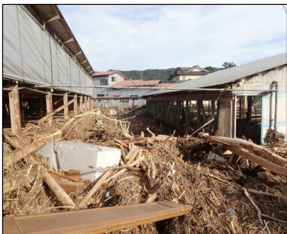
図3 畜舎に大量の土砂・瓦礫が流入(農場 D)
