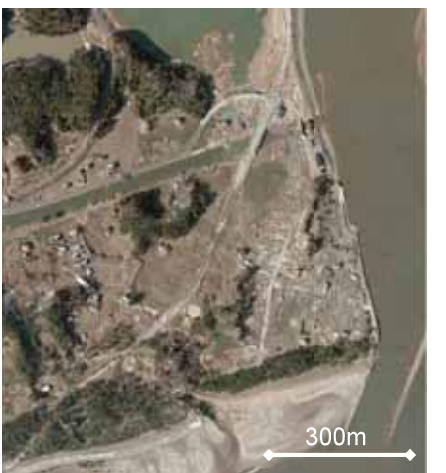
被災後（平成23年3月12日撮影）
