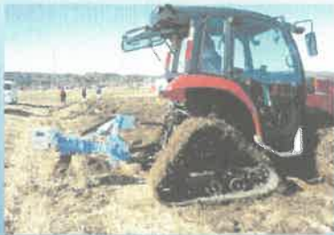
排水対策試験(2/2施工)
