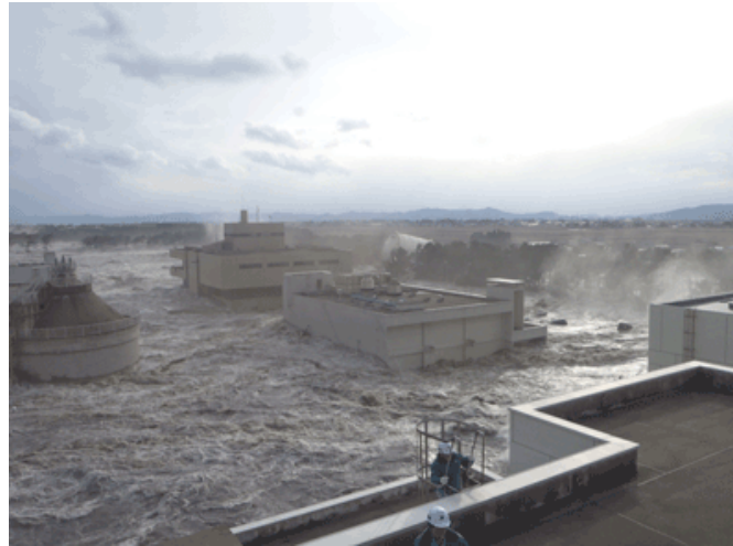
処理場水没状況
