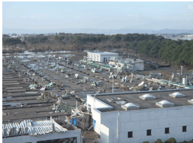
水処理施設被災状況
