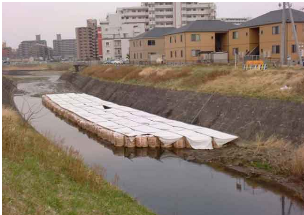
写真 2 - 9 要害川 仮設沈澱池
