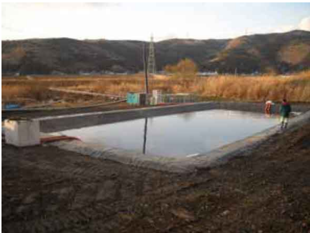
写真 2 - 1 3 真野川 仮設沈澱池
