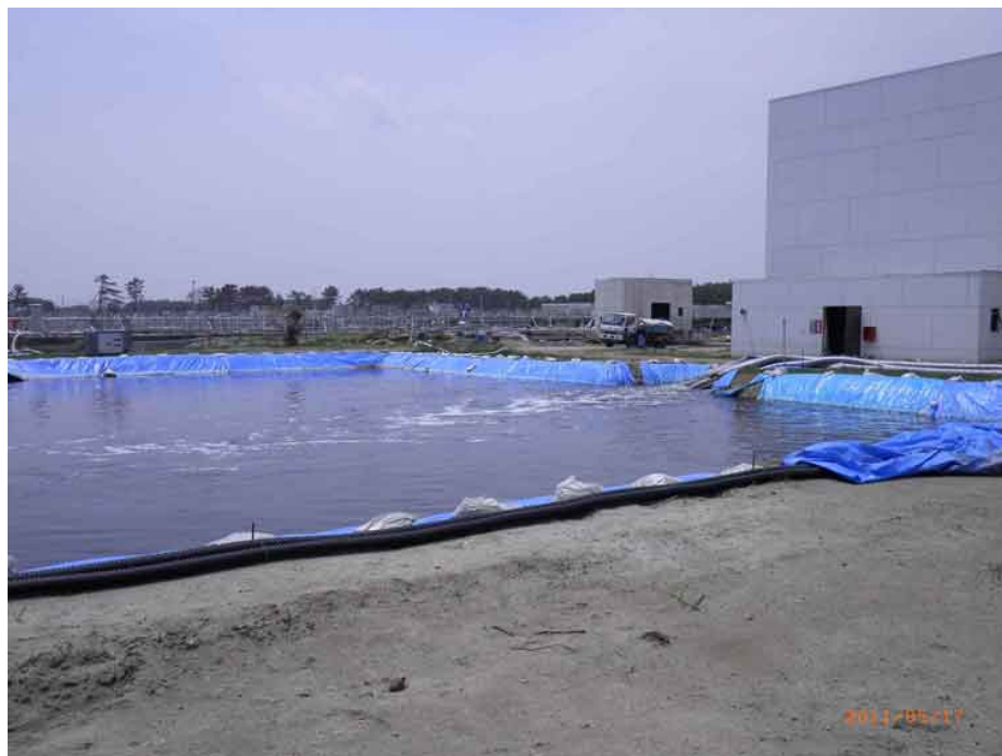
写真 2-1-1 県南浄化センター 仮設沈澱池
