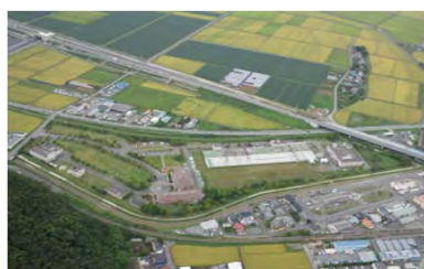
石巻浄化センター
