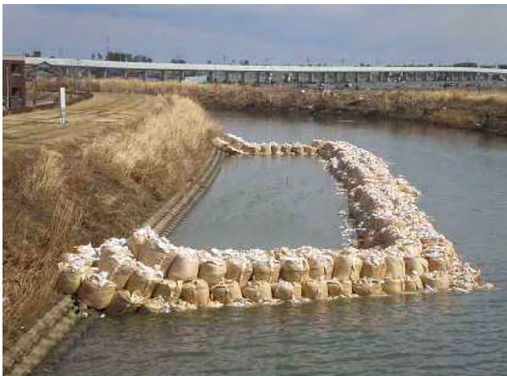
写真2-10 増田川 仮設沈殿池
