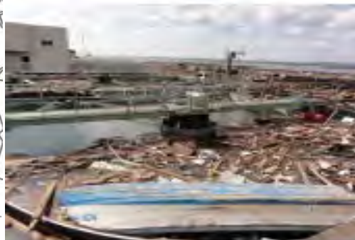
最終沈降池被災状況
