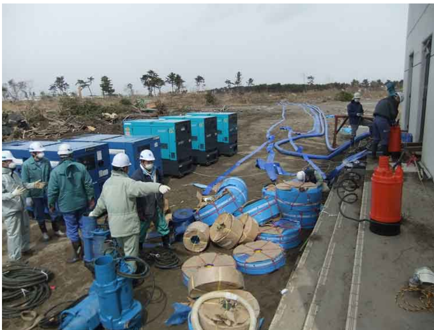
写真 2 - 3 作業状況（県南浄化センター）
