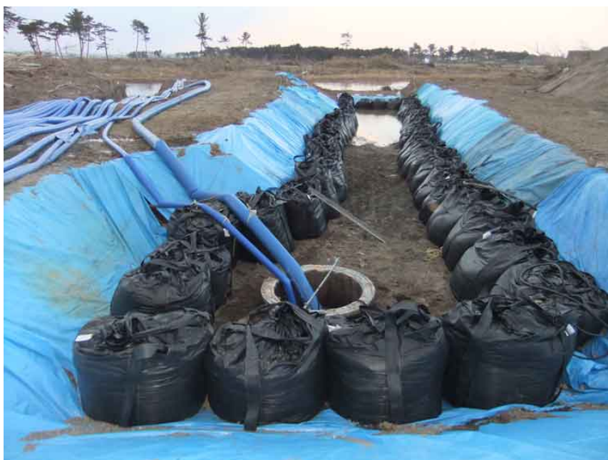
写真 2 - 4 緊急排水状況（県南浄化センター）
