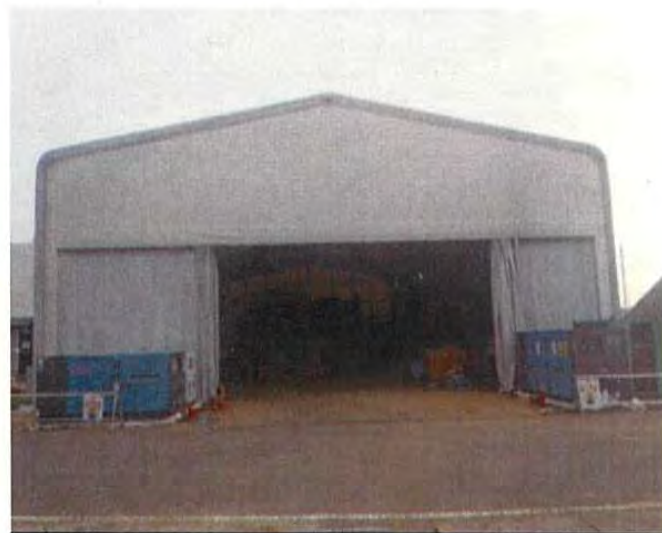
写真-6 仮設汚泥処理テント設置（堆積汚泥処理）
