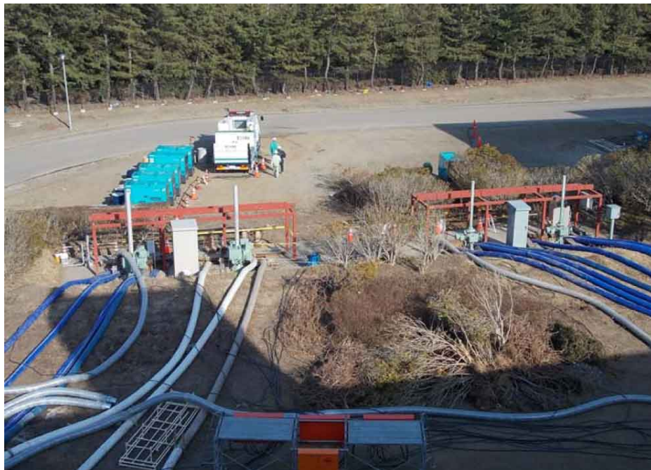
写真 2-1 仮設ポンプ設置状況（仙塩浄化センター）
