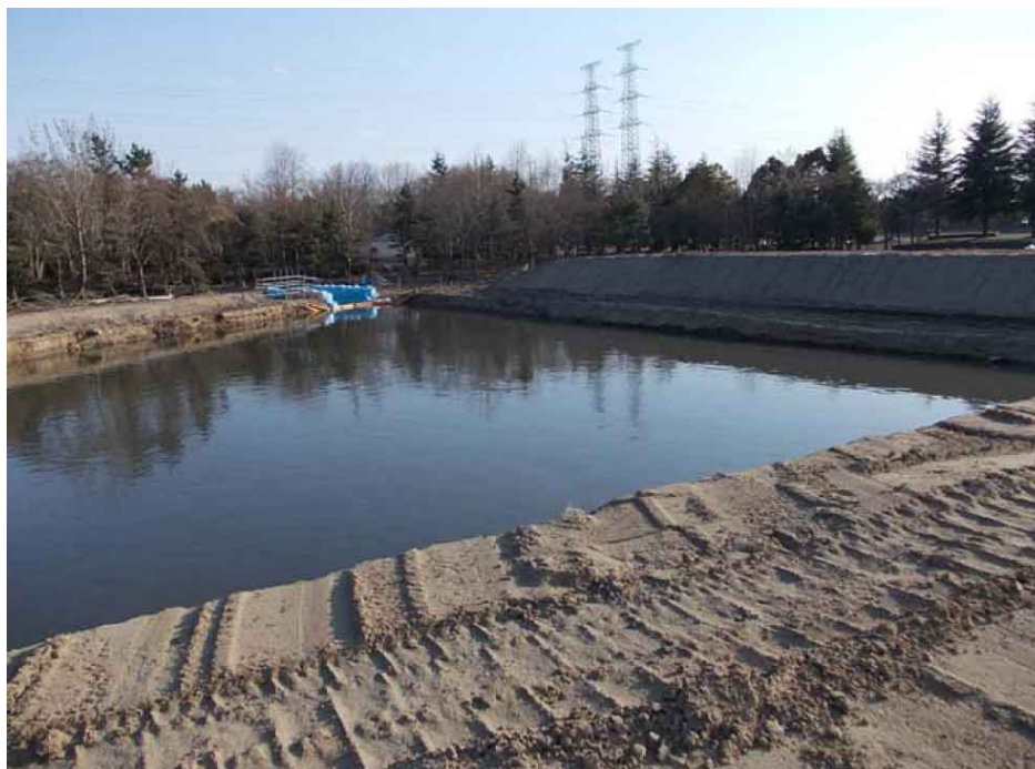
写真 2 - 7 多賀城緩衝緑地公園内 仮設沈殿池
