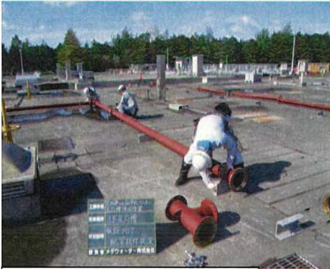
写真-3 簡易曝気設備設置状況
