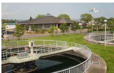
鹿島台浄化センター
