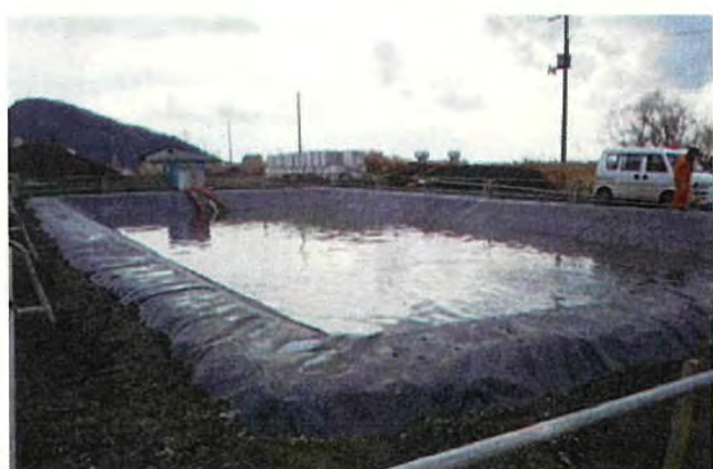
写真-7 石巻第2ポンプ場仮沈澱池作成 旧北上川へ放流
