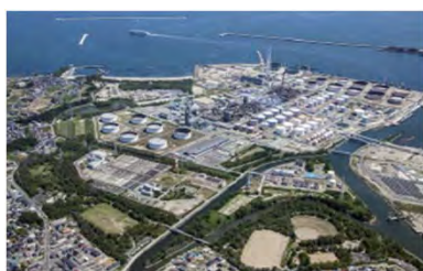
仙塩浄化センター
