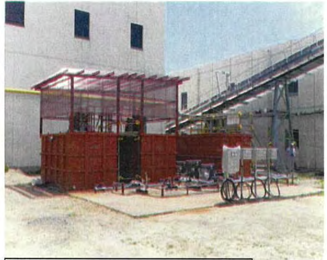
写真-4 仮設汚泥処理施設設置
