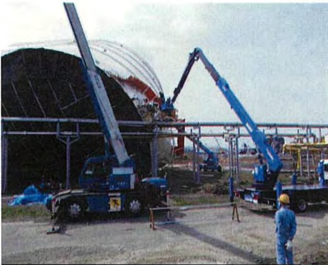
写真-5 被災施設撤去状況（ガスホルダー）
