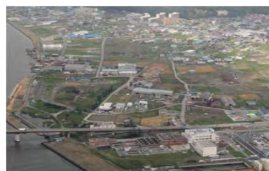
石巻東部浄化センター
