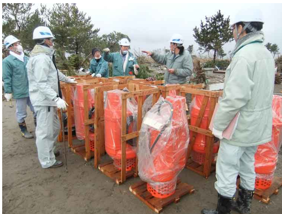
写真 2-2 作業状況（県南浄化センター）
