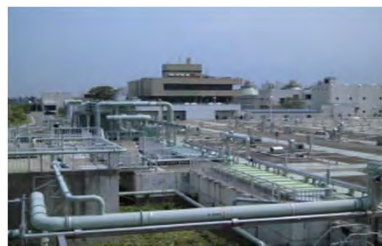
県南浄化センター
