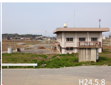
農地復旧工事の様子
