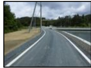
復旧した林道 日向貝線 (気仙沼市)
