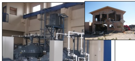
復旧した花笠第2排水機場 (山元町)
