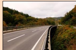
完成状況(宇津野1号栈道工)
