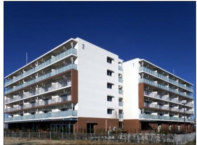
災害公営住宅整備状況 (多賀城市宮内地区)
