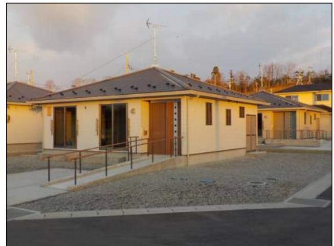
災害公営住宅整備状況 (山元町宮城病院周辺地区)
