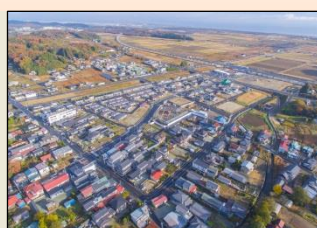
新坂元駅周辺地区(山元町)
