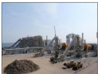
焼却炉稼働時の状況 (石巻ブロック)
