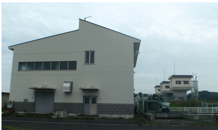
仮屋河道排水機場の外観
