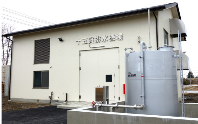
十五貫排水機場の外観
