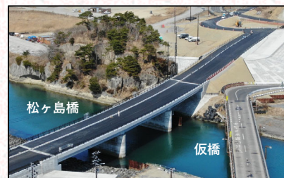
開通した松ヶ島橋
