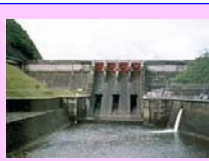
釜房ダム 管理者：国土交通省 所在地：柴田郡川崎町小野 >釜房ダム管理所(国) HPへのリンク
