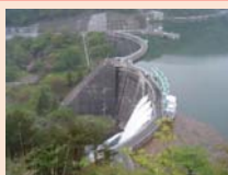
仙台環境開発 大倉ダム※ 管理者：宮城県 所在地：仙台市青葉区大倉
