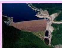
七ヶ宿ダム 管理者：国土交通省 所在地：刈田郡七ヶ宿町字切通 >七ヶ宿ダム管理所(国)へのリンク
