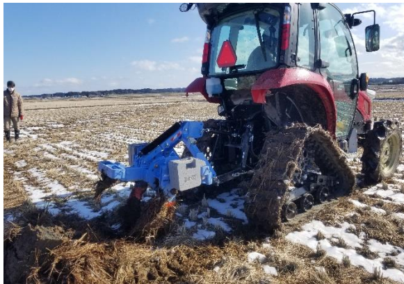
補助暗渠施工 (2月、4月)
