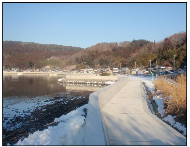
【折立海岸の護岸工完成状況】
