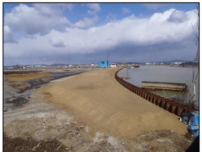
【定川の築堤盛土(暫定)完成状況】
