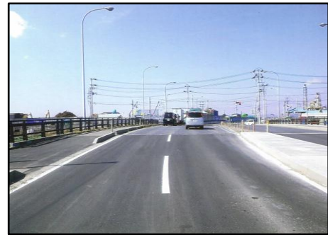
【(一)石巻港インター線 石巻市門脇地内】
