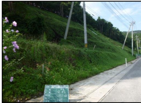
【(主)石巻鮎川線 石巻市渡波地内】
