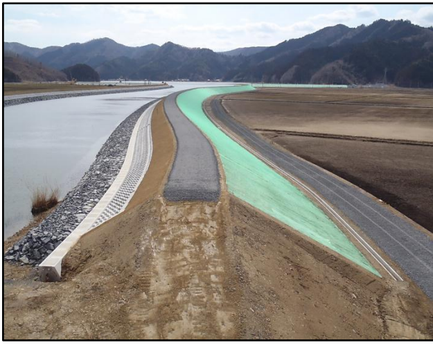
【富士川の築堤盛土成状況】
