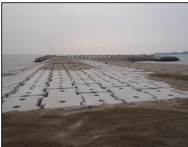
【浜市海岸の突堤工完成状況】
