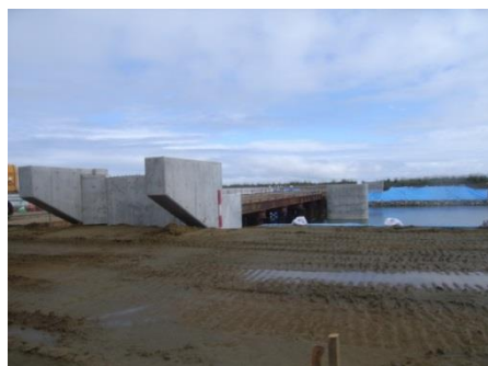
【(一)石巻松島自転車道線 浜市橋 下部工完成状況】
