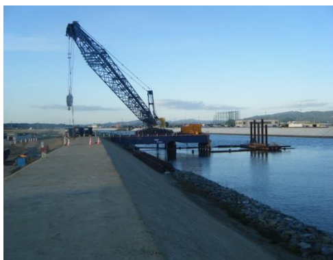
【(都)矢本門脇線 (仮)新定川大橋施工状況】
