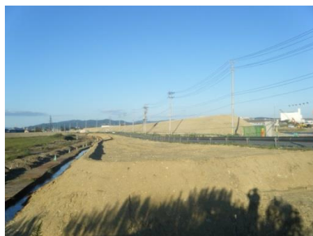
【(一)石巻工業港矢本線 大曲災害復旧工事施工状況】
