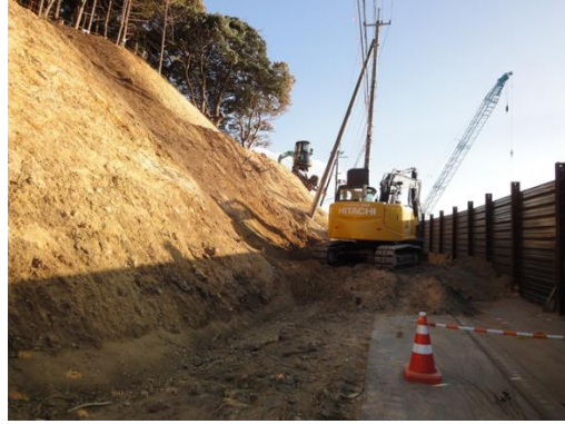
【(主)石巻鮎川線 清水田浜 災害復旧工事施工状況】
