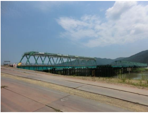
【(国)398号 新北上大橋 上部工架設工事状況】
