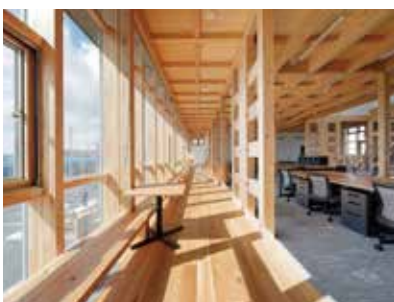
CLTを使用した建物の内部
