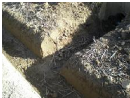
写真1 明きよと排水溝をつなぐ
