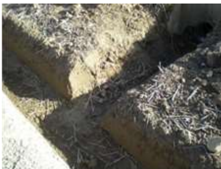
写真1 明きよと排水溝をつなぐ
