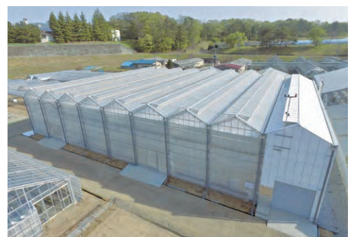
最先端の試験研究施設 軒高6m、最新の環境制御機器を備えた施設
