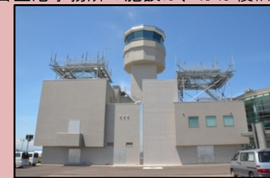
▲完成した仙台空港内の新管制塔
