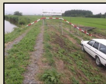
▲定川堤防の丁張 ※丁張とは、構造物を建設する際に用いる目安の定規のことです
