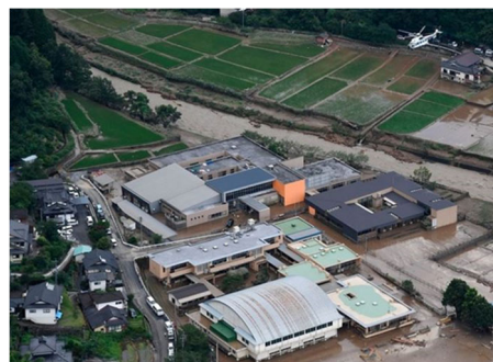
令和2年7月豪雨の被害（熊本県球磨村） 特別養護老人ホーム「千寿園」
