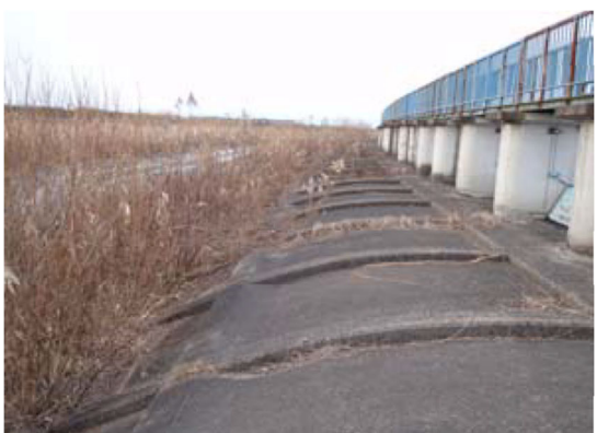
南谷地遊水地越流堤
