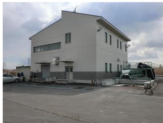
仮屋河道排水機場
