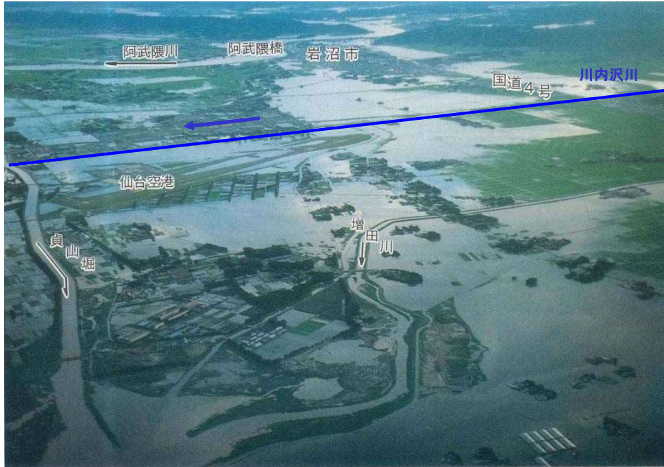
○平成6年9月22日洪水状況（川内沢川下流）
