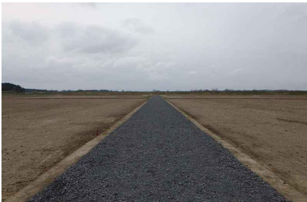
支線道路(区画整理後)
