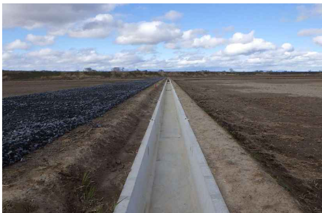
用水路工(区画整理後)
