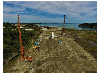
平成28年 10月 地盤改良施工状況
