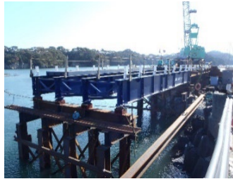
平成24年 12月 松ヶ島橋仮橋設置状況
