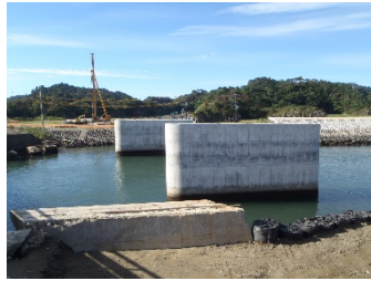
平成28年 9月 下部工施工完了
