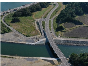
令和4年 9月 松ヶ島橋仮橋撤去工事施工完了
