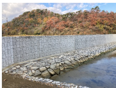
令和4年 11月 宮戸道路改良(護岸)工事施工完了
