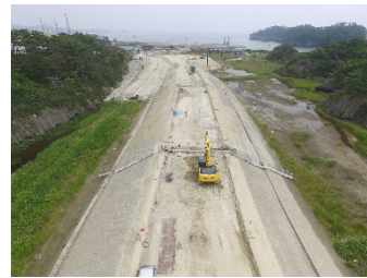
平成29年 6月 道路盛土施工状況
