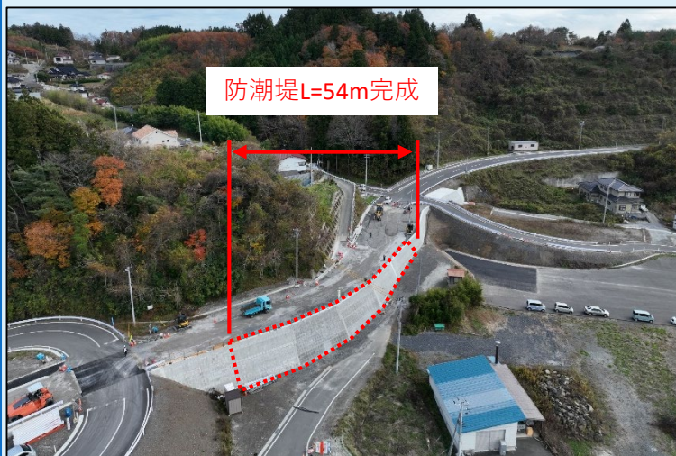
【全景写真】 R5.11.29撮影
