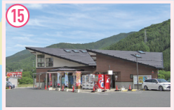
15 道の駅石仙人峠 住所 〒026-0055 岩手県釜石市甲子町第7地割155-4
