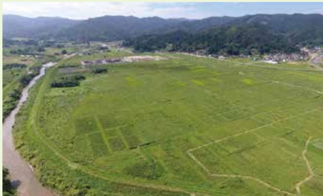
【柳地区 復旧前】
