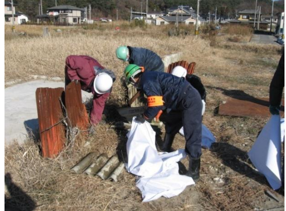
【石巻市内で実施したアスベスト含有廃棄物の回収作業】
