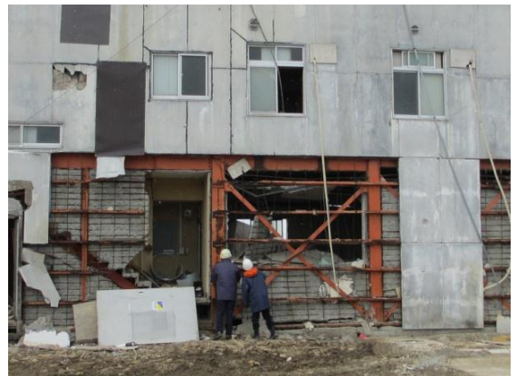
【被災建築物の現地調査】
