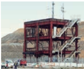
防災対策庁舎
