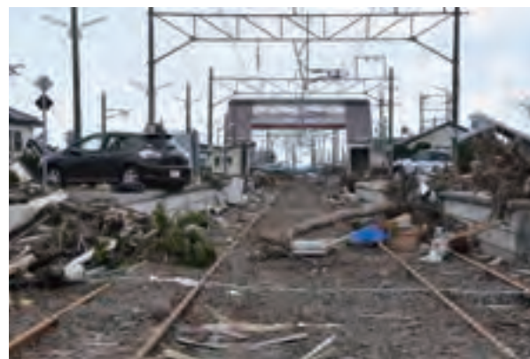
津波被災直後の旧JR山下駅
