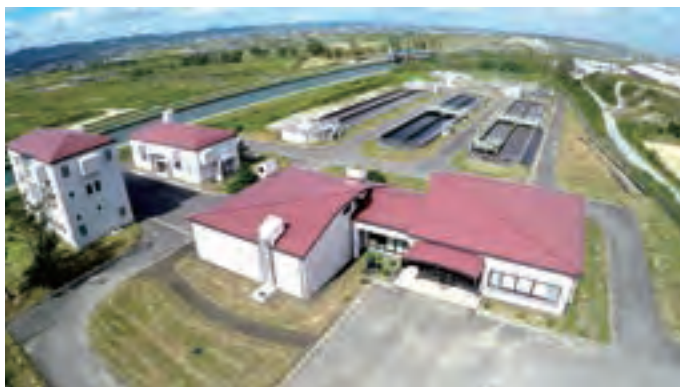
山元浄化センター（復旧後）
