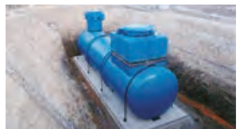
耐震性貯水槽（山下）
