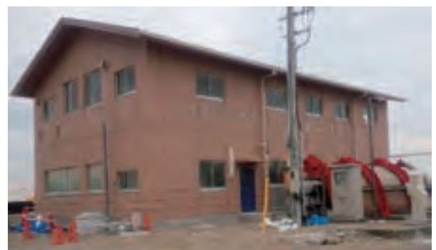
花笠第2排水機場
