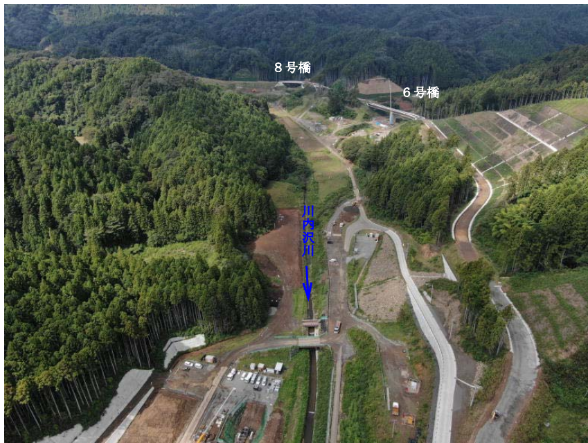
ダムサイトから8号橋付近（施工中） 令和5年9月撮影
